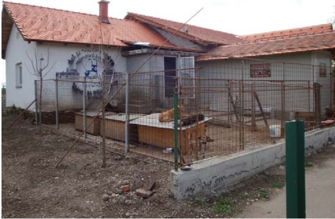
Baufortschritt in Cakovec
