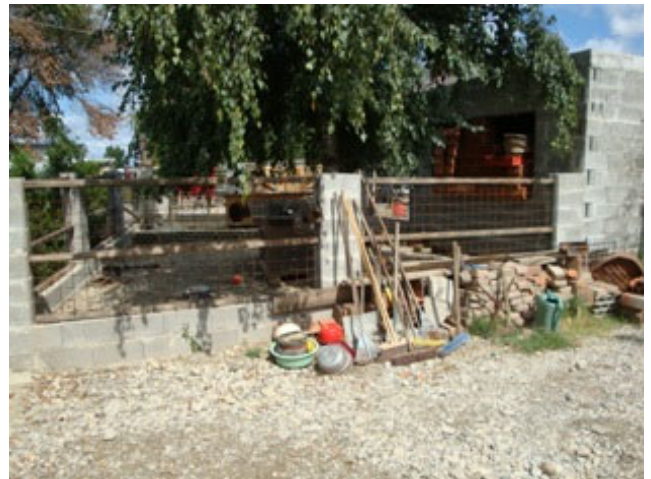
Großer Welpenbereich - rechts eine Ecke des Gebäudes noch ohne Dach
