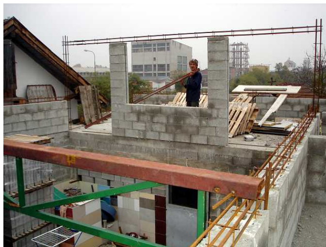
Branko bereitet den Dachstuhl vor, damit das neue Haus über den Winter trocken bleibt.
