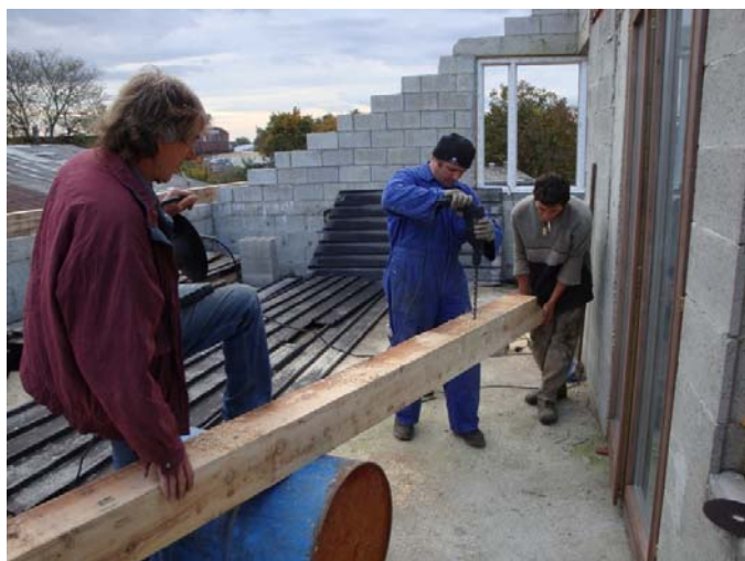
Arbeiten am Dachfirst
