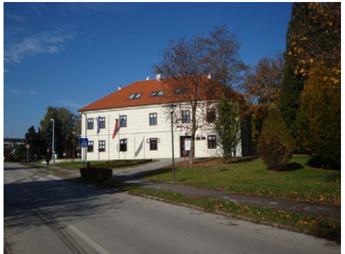
Obnovljena zgrada službe u Ivanić Gradu
